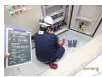
電圧降下測定（計器差確認）
