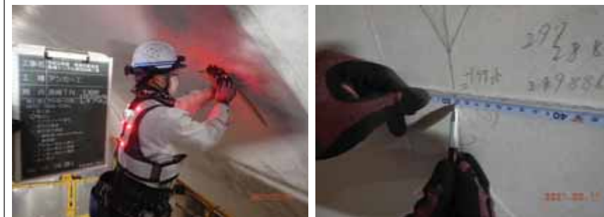
墨出工（ラックブラケットアンカー打設位置）
