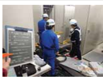
高圧ケーブル耐圧試験
