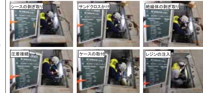
配線工-ケーブル接続（レジン工法）
