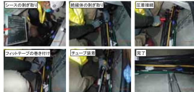
配線工-ケーブル接続（直線接続 水没対応型常温収縮工法）
