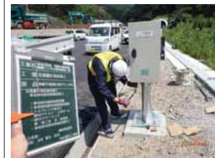
制御盤設置
