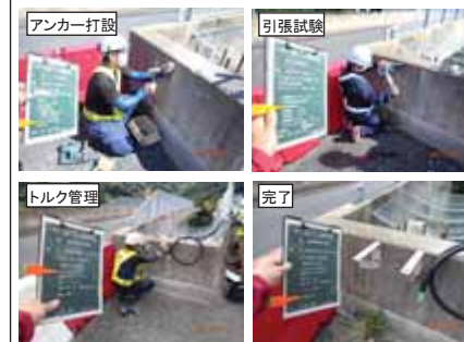
分岐点滅灯設置金具取付
