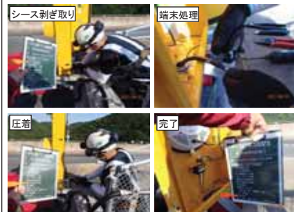
分岐点滅灯器具接続
