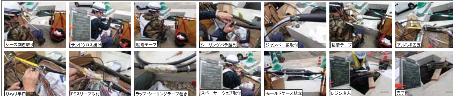
メタルケーブル直線・分岐接続（解体可能型）
