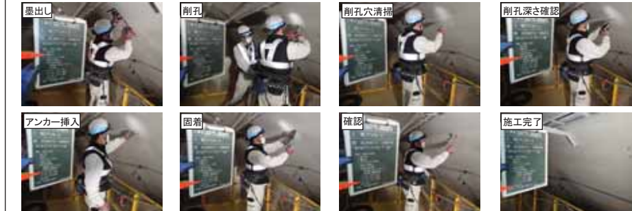
照明器具アンカー打設
