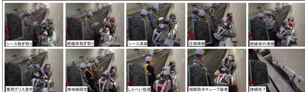
高圧ケーブル直線接続（常温収縮型）確認 立会者 岩崎補助監督員
