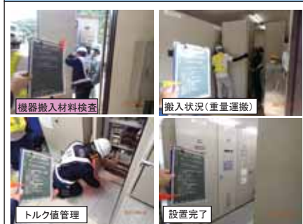
トンネル照明制御装置 設置
