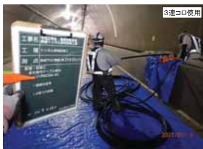
監査路多孔管ケーブル敷設
