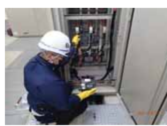
絶縁抵抗測定（高圧ケーブル）
