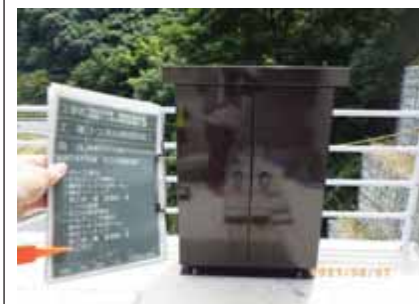
坑口分電盤設置
