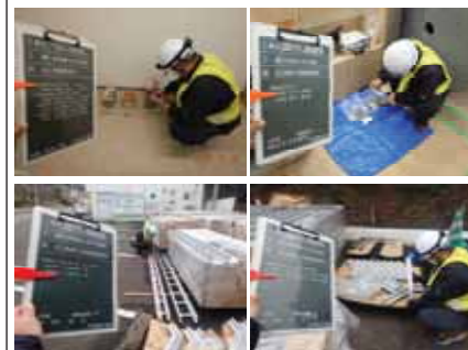
材料搬入（自主検査） 以後共通 アンカー ボルト・ブラケット・ケーブルラック
