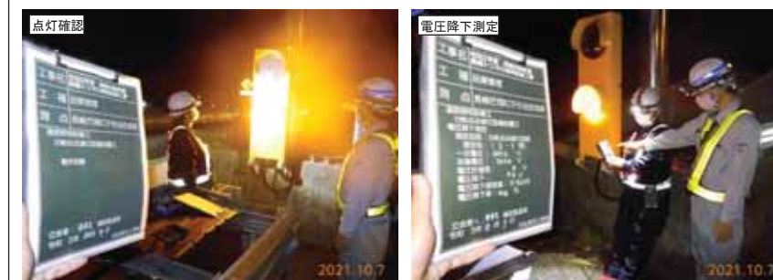
分岐点滅灯点灯・電圧確認
