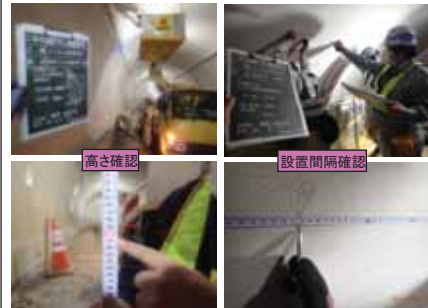
施工立会 照明器具設置高さ・間隔確認
