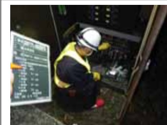
絶縁抵抗測定（上り線施工前）
